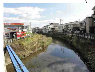
江の川橋下流
