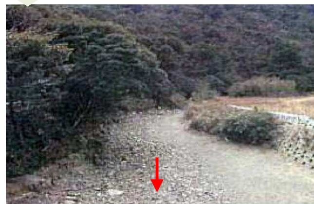
渇水期：河川が枯渇し正常な機能が失われる 中小路頭首工上流部 [H16.2]
