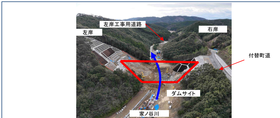
ダム予定地点上流より下流を望む (令和5年12月撮影)
