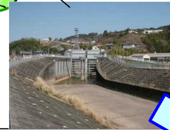
日下川放水路付近 改修前
