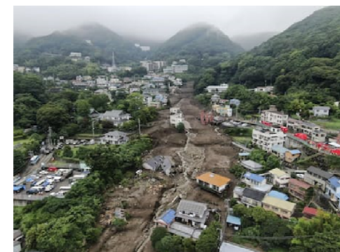
(R3.7月静岡県熱海市土石流)
