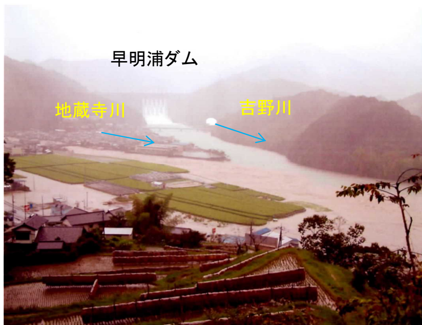
地藏寺川合流点付近(平成16年台風23号)
