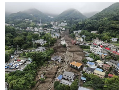
(R3. 7月静岡県熱海市土石流)
