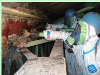
吹付け石綿の除去作業の様子
