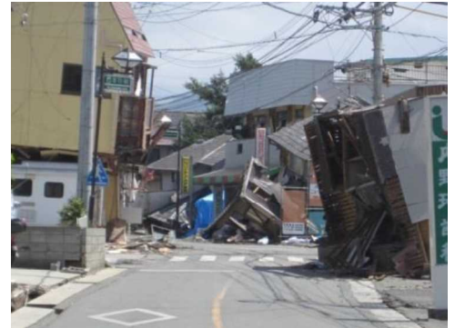
地震で損壊した建物
