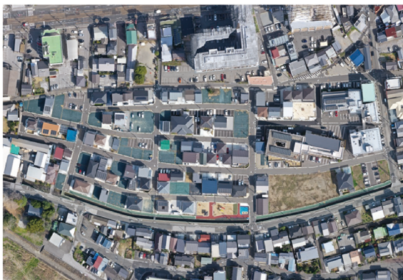
施行後区域全景
