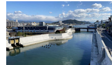
【高知港海岸】 (海岸堤防の耐震対策)
