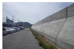
11百万円⇒3百万円 海岸堤防の耐震補強状況
