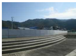
海岸堤防の耐震補強状況
