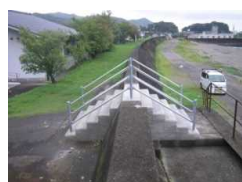
コンクリートによる陸こうの閉鎖
