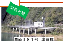
国道381号 津賀橋
