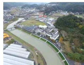
日下川（堤防整備）
