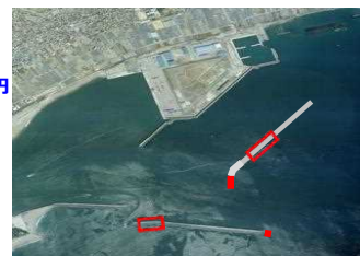
高知港防波堤の整備
