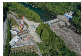
【北川道路】 (四国8の字ネットワークの整備)
