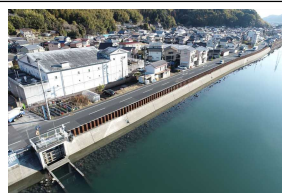
【下田川】 (河川堤防の耐震対策)
