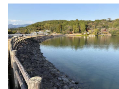
【内原野池地区】 (ため池の耐震対策)
