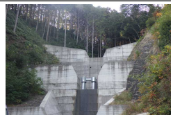
【汐満川】 (砂防堰堤の整備)
