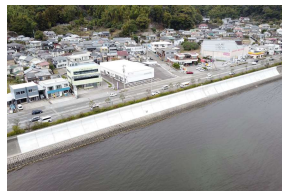
海岸堤防の耐震対策
