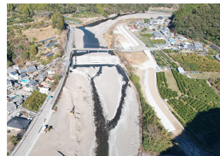
【安芸川】 (河川の堤防整備)
