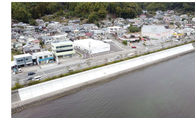
【高知港海岸】 (海岸堤防の耐震対策)
