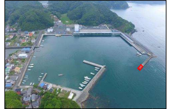
田ノ浦漁港 防波堤の粘り強い化整備
