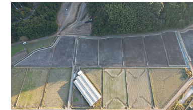
【志和地区(四万十町) ほ場整備】
