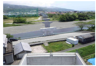
高知東部自動車道 安芸道路(安芸市)
