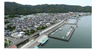
海岸堤防の耐震対策
