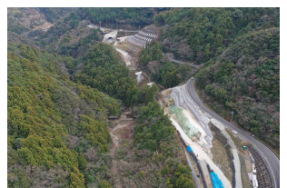
国道494号佐川～吾桑BPの整備
