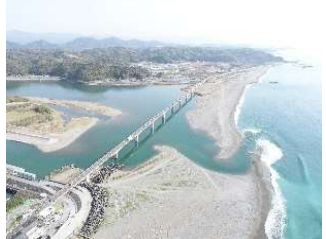
県道須崎仁ノ線(仁淀川河口大橋)
