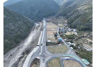
国道493号 (北川道路2-2工区)
