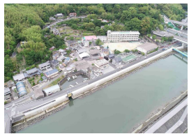
河川堤防の耐震対策
