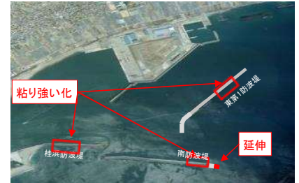
高知港防波堤の整備
