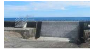
コンクリートによる陸こうの閉鎖
