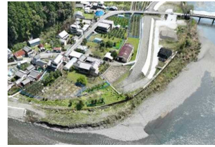
【安芸川】 (河川の堤防整備)
