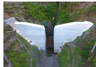
【谷山川】 (砂防関係施設の整備)
