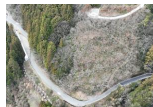
国道439号 川井拡幅工区 (大豊町)
