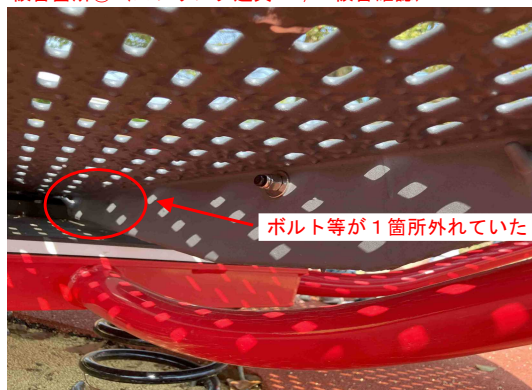
被害箇所② (スプリング遊具: 4/18被害確認)
